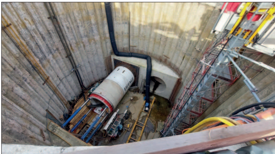
Bild 3: Die Tunnelbohrmaschine in der Startgrube Quelle: Bezirksregierung Arnsberg
